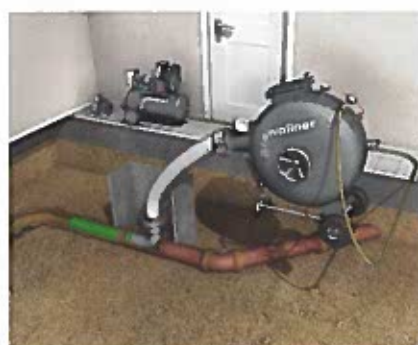
Inversion mit Drucktrommel
